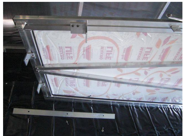
Bild 10: Werkseitig montierten Alu-Winkel 50x30x2mm durch Lösen der Schrauben von den Seitenteilen abnehmen und vorerst zur Seite legen.
