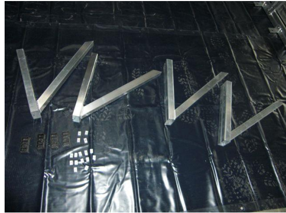
Bild 28: Mittelunterstützungen und Kleinteile (Kunststoffkappen und Einsteckmutter) für die Montage der Sitzbänke bereitlegen.
