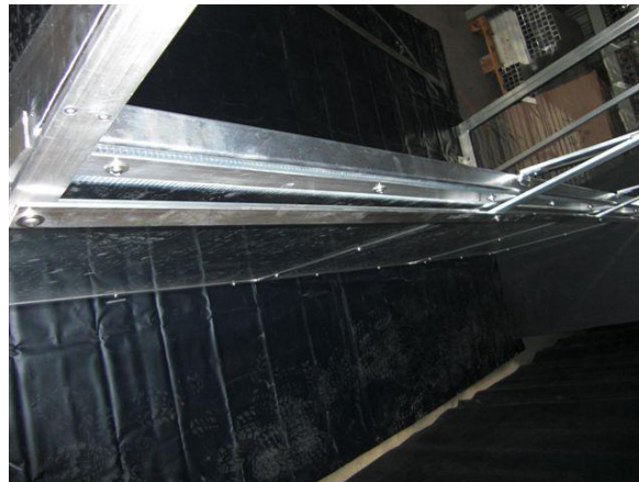
Bild 20: Winkel 40x30x4mm an den beiden Seitenteilen und den vorher montierten Dachbögen an der Rückseite befestigen. Dafür Linsenkopfschrauben DIN7380 M8x16 und Unterlegscheiben DIN9021 Ø 8,4mm verwenden. Achtung: Vorerst Schrauben nur leicht eindrehen!
