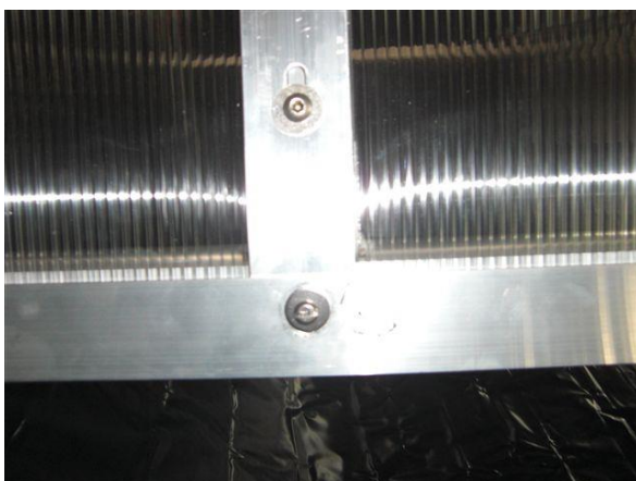
Bild 25 + 26: Winkel 50x30x2mm an der Dachtraverse und den Seitenteilen mit Linsenschrauben DIN 85 M6x20 und Unterlegscheiben DIN 9021 Ø 7,4mm befestigen. Jetzt können auch sämtliche Schrauben, die vorher nur leicht eingedreht wurden, fest angezogen werden.
