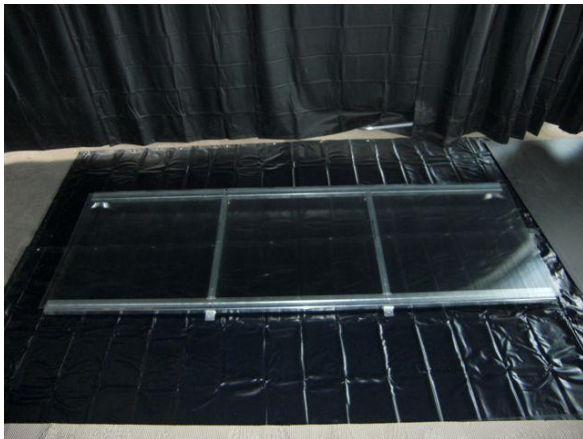
Bild 3: Rückwand mit der Kammerseite auf den Boden legen, Schutzfolie der Hohlkammerplatten 990 x 970mm abziehen und Platten auflegen (3 St. bei 3m-Kabine, 4 St. bei 4m-Kabine, 5 St. bei 5m-Kabine).
