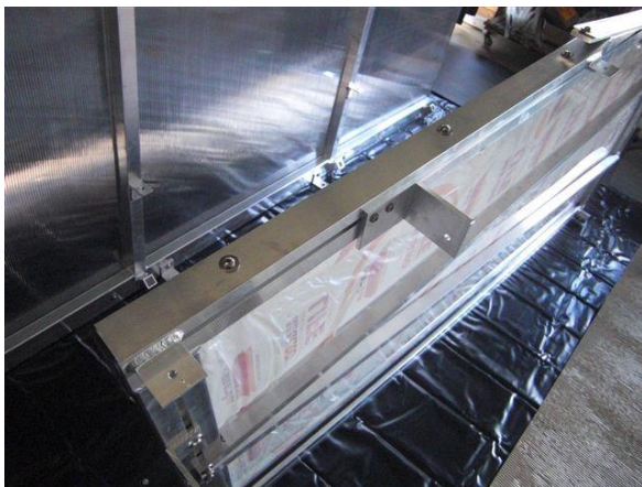
Bild 9: Seitenteile aufrichten und auf die Vorderseite legen.
