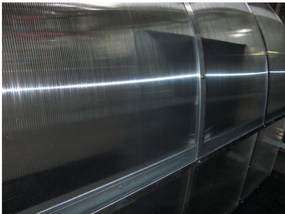
Bild 23: Flach 50 x 2mm, 1.980mm lang (aus dem Zubehör – bei 3m-Kabine 2 Stück, bei 4m-Kabine 3 Stück, bei 5m-Kabine 4 Stück) auf Höhe der Dachbögen zwischen Winkel und Hohlkammerplatte stecken, zusammen mit den Hohlkammerplatten der Dachwölbung folgend nach unten biegen und mit Linsenschrauben DIN7380 M8x16 und Unterlegscheiben DIN9021 Ø 8,4mm festschrauben. Mit der Befestigung von unten beginnen und parallel und gleichmäßig nach oben vorarbeiten; gemeinsam mit der in Bild 22 beschriebenen Montage der Flachs 50x2mm an den Seitenteilen.
