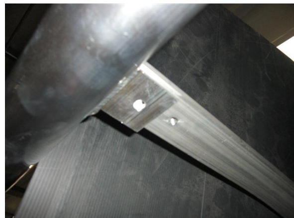
Bild 18: Dach-Mittelbögen mit der anderen Seite mit Linsenkopfschrauben DIN 7380 M8x16 an die angeschweißten Laschen der Dachtraverse schrauben.
