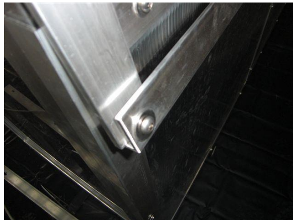
Bild 22: Die in Bild 19 entfernten Flach 50x2 und Flach 10x5mm nun wieder am Seitenteil mit den vorher herausgedrehten Schrauben und Unterlegscheiben befestigen. Die Scheiben dafür, der Dachwölbung folgend nach unten biegen. Das Flach 10 x 5mm wieder wie gehabt unterklemmen. Mit der Befestigung von unten beginnen und parallel und gleichmäßig nach oben vorarbeiten; gemeinsam mit der in Bild 23 beschriebenen Montage des Flachs 50x2mm an den Mittelbögen. Achtung: Vorerst Schrauben nur leicht eindrehen!
