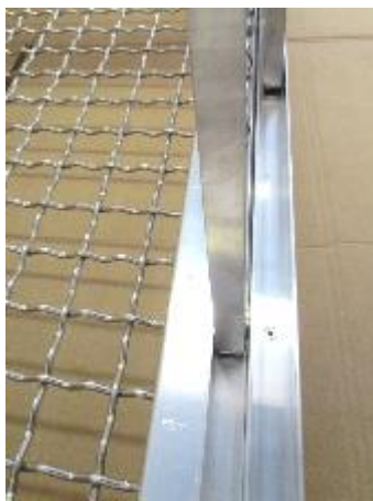
Führungsschiene Schiebetür im Unterteil
